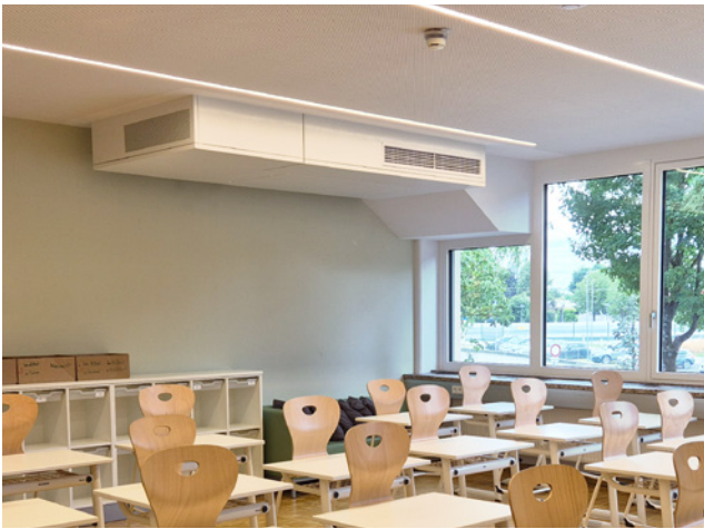
Einbausituation, mit Schalldämpfern, seitlich unten ausblasend, teiltintegriert in der Zwischendecke
