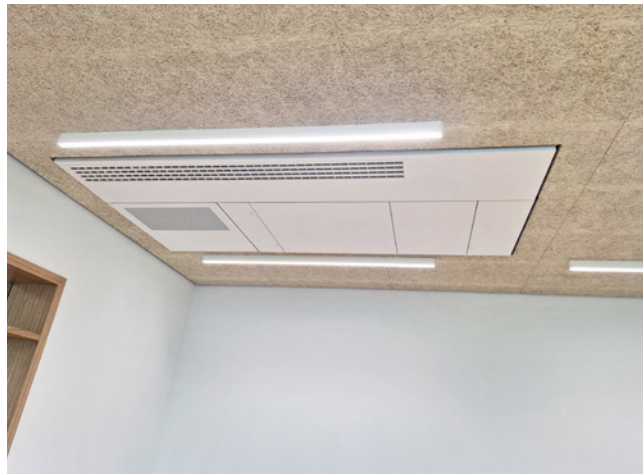
Einbausituation, mit Schalldämpfern, deckenbündig
