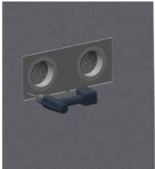
Mit 6 mm Bohrer die EPP Wanddurchführung vorbohren
